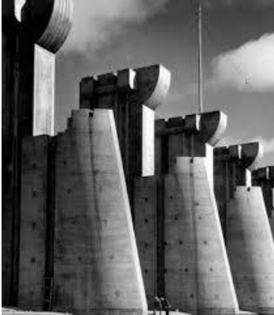
la diga di Fort Peck 1936
